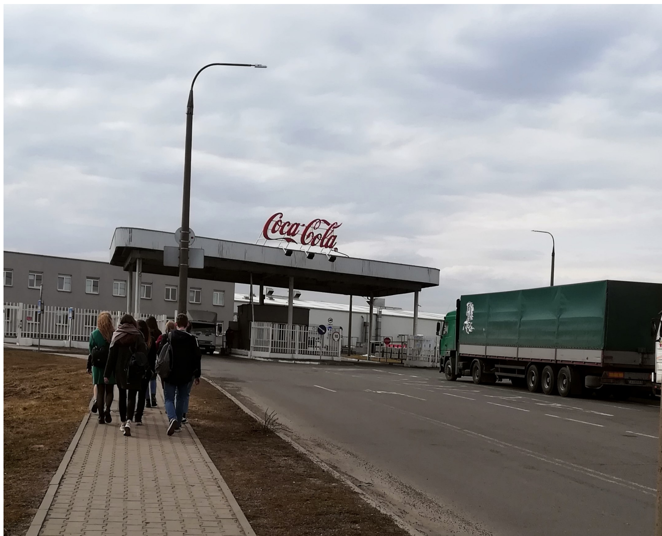
Завод “Кока-Кола”. Фото Дарьи Бондар
